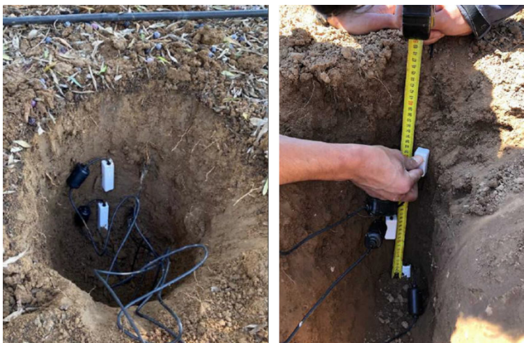
Figura 5: Instalação de sensores modulares.
